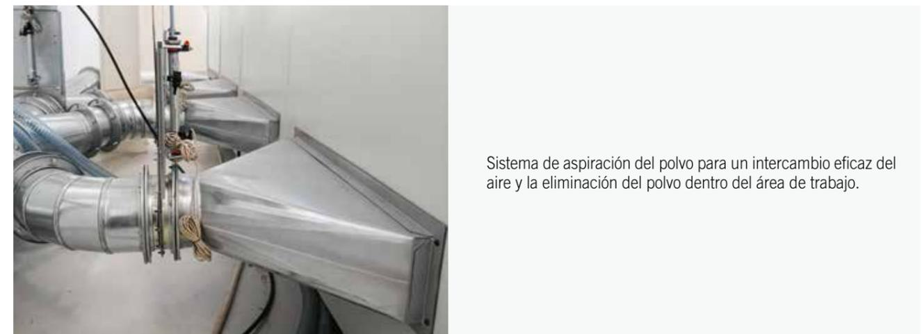
Sistema de aspiración del polvo para un intercambio eficaz del aire y la eliminación del polvo dentro del área de trabajo.
