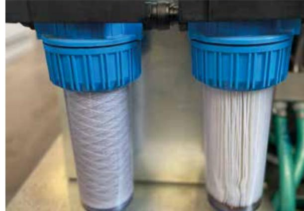
Doble cartucho filtrante de propileno con alambre retorcido y plisado para filtrar sedimentos del agua de red entrante a 10 micras y 1 micra respectivamente. Gracias a la presencia de sensores, se supervisa el estado de obstrucción y se señala la sustitución mediante avisos en el panel de control.
