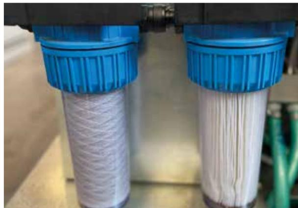
Cartucho filtrante duplo de propileno com fio roscado e plissado para filtrar os sedimentos da água da rede de entrada a 10 e 1 micrones, respectivamente. Devido à presença de sensores, o estado de entupimento é monitorizado e a substituição é assinalada com avisos no painel de controlo.
